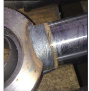
Рис. 2. Кольцевой шов соединения «проушины» со «штоком» гидроцилиндра
